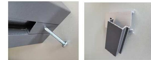
Setzen sie die Anfangsleiste ein und stecken die Paneele in die Pfostennut
